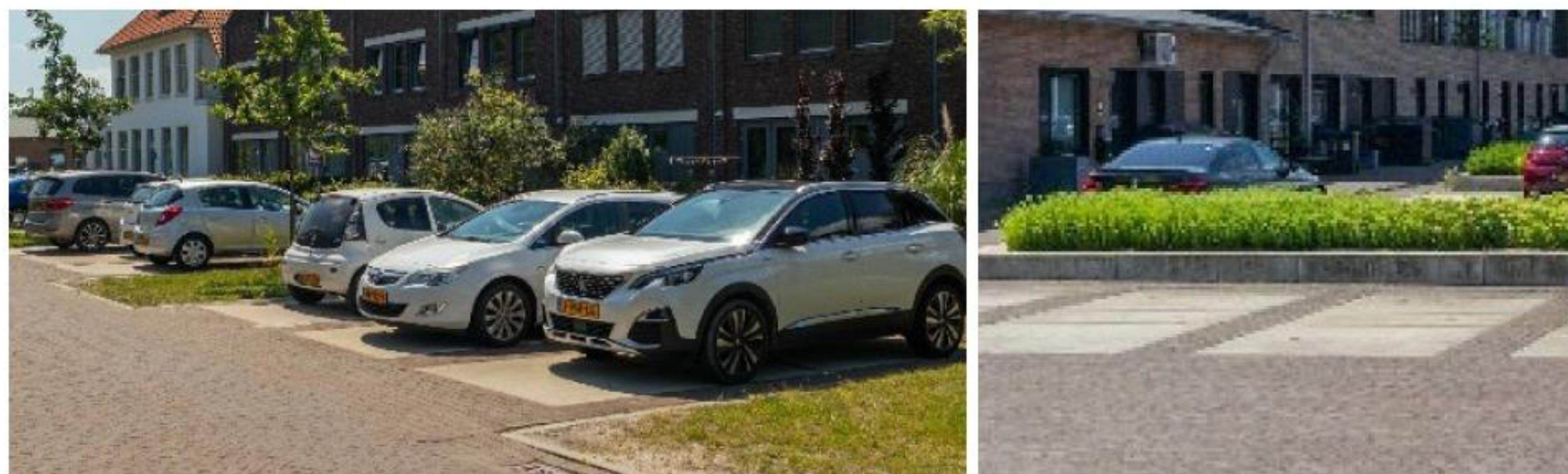
Hergebruik stelconplaten in het parkeren
